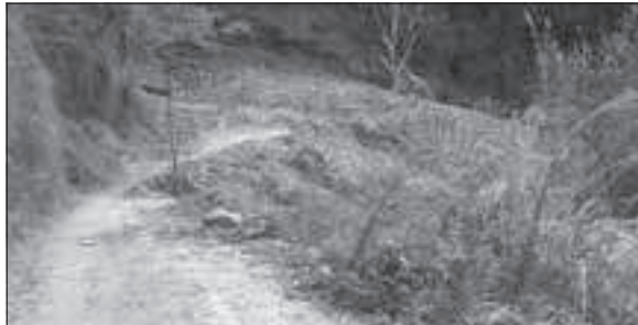
Una frana alla contrada Triggiano
